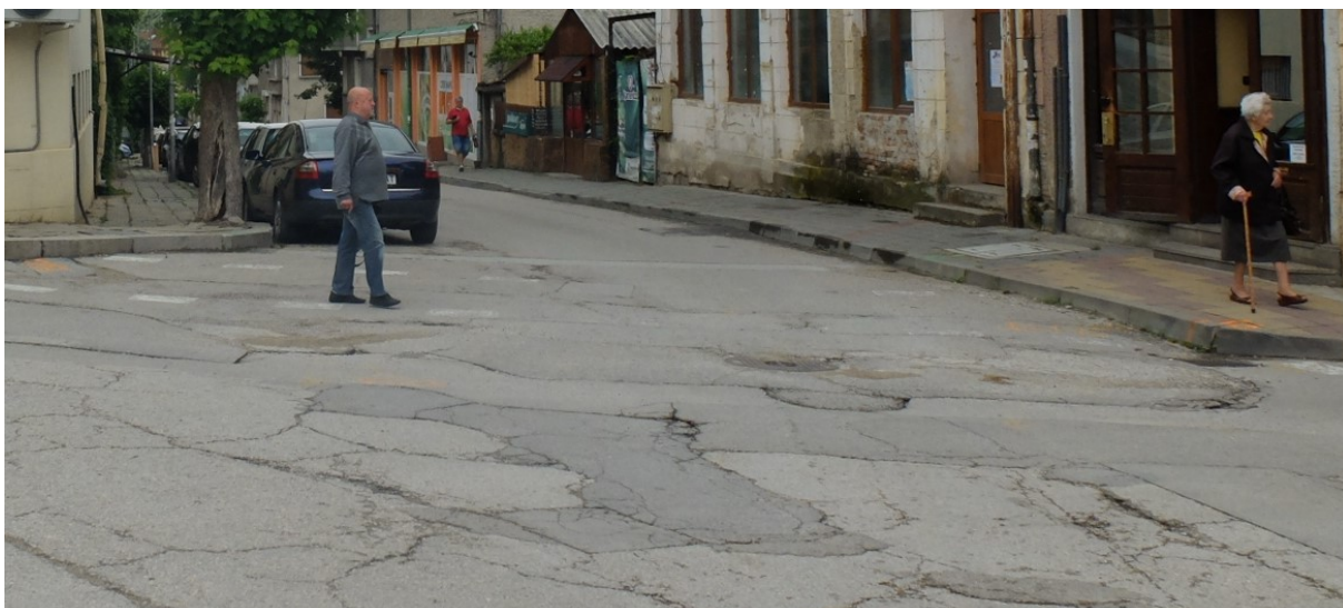
Снимка №3: Повреди по уличната настилка
