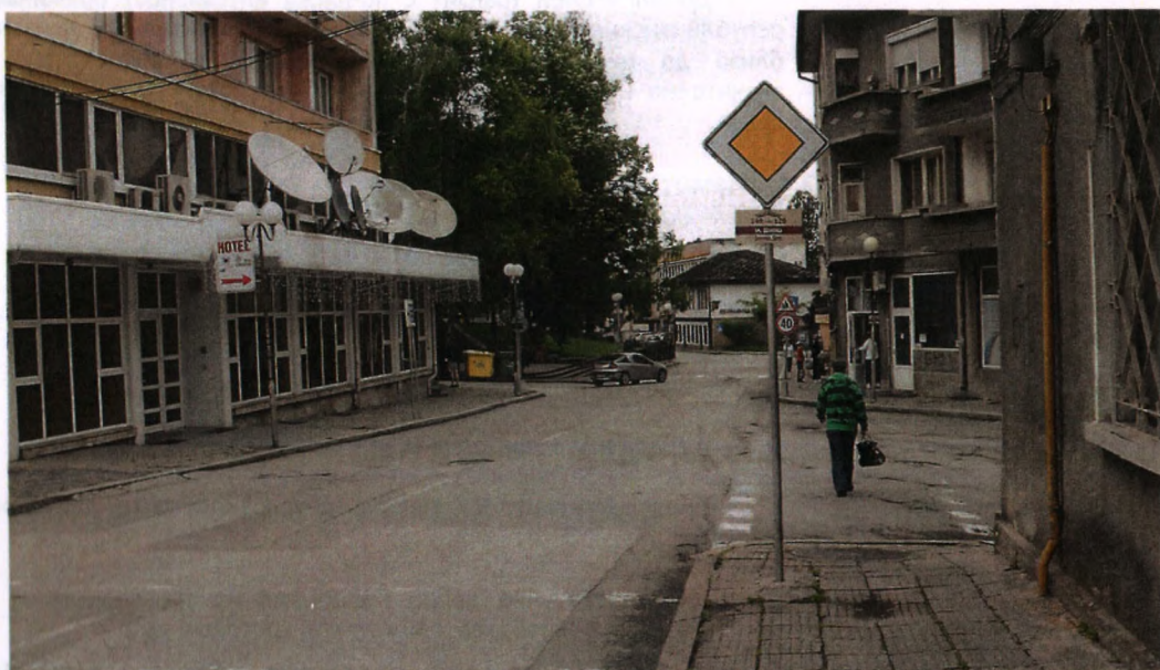
Снимка № 1: Лошо състояние и неправилно маркирани пешеходна пътека - трябва да са тип „зебра“
